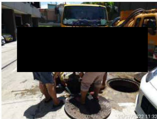
การสูบน้ำมัน และตะกอนระบบบำบัดน้ำเสีย
