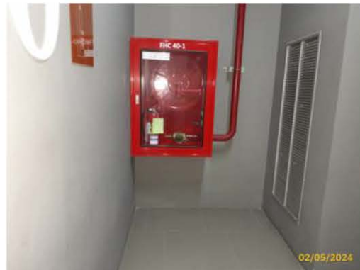
ตู้เก็บสายฉีดน้ำดับเพลิงบริเวณโรงลิฟต์
